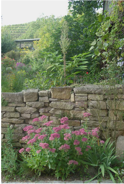
2.3.9 oben links Bruchsteinmauer mit Pflanzstreifen davor
