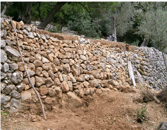
2.3.6 oben Nur zwei Steine hoch ist diese Friesenmauer – dennoch eine Augenweide.
