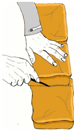
5.1.9 Kleinere Steine können direkt auf der Mauer angepasst werden. Dazu wird der Stein unter den benachbarten geschoben und eine Markierung geritzt...
