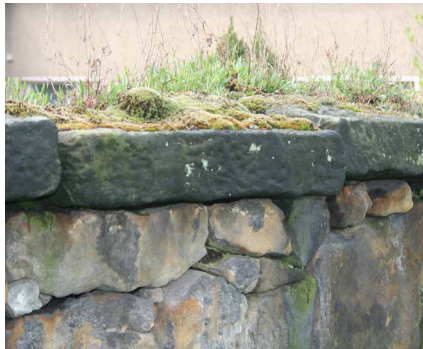
5.8.5 oben rechts Die Mauerkrone wird in ein paar Jahren vom Mauerpfleger eingefasst sein.
