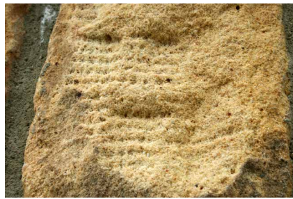
5.1.5 unten links Gekrönelte Oberflächen sind selten, da sie ein spezielles Werkzeug erfordern.
