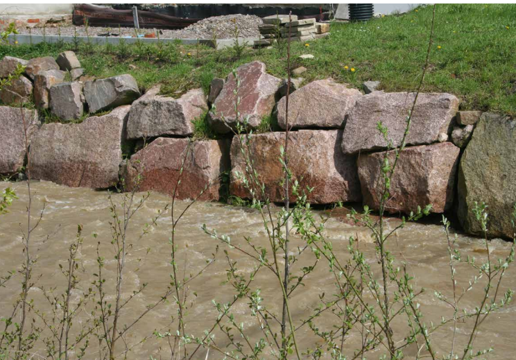
6.3.2 Durch die stabilen und großen Randsteine erhält der Bachlauf seine Form.
