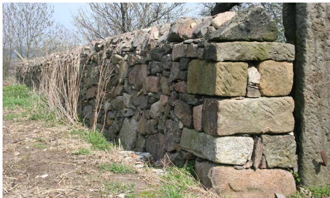
5.8.7 unten Selten sieht man eine solch gelungene Mauerkrone, die wie ein Spitzdach das Regenwasser ableitet.
