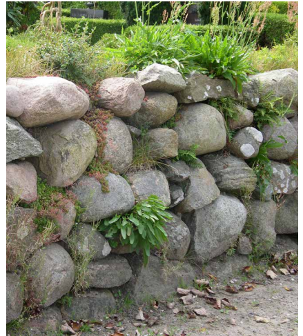
6.7.4 links oben Für Gartenliebhaber sind diese Hochbeete eine Rücken schonende Alternative zum Bo- denbeet. Hier wurden aus Granitsteinqua- dern Hochbeete geschaffen, die mit Erde aus- gefüllt, eine sehr schöne Pflanzfläche bieten.
