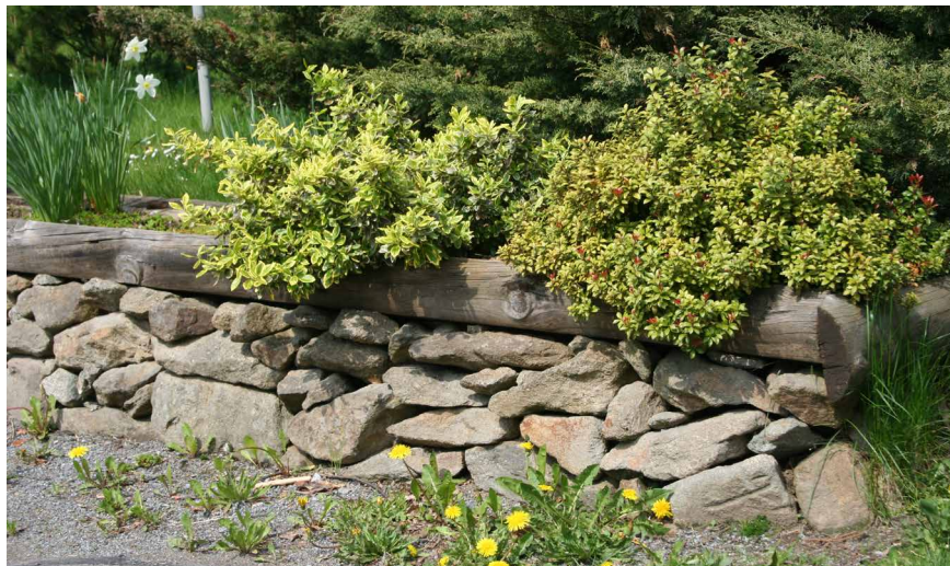
6.7.16 Pflanzmauer mit einer Mauerkrone aus zwei Holzstämmen, die das Pflanz- beet begrenzen.
