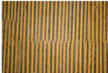
5.1.3 oben links Mit dem Spitzzeisen bearbeiteten Flächen sind typisch für alte Mauern.
