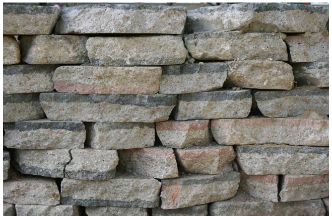
6.5.2 ... doch aufeinander geschichtet lassen sich die Recycling-Steine zu einer schönen Trockenmauer verbauen.
