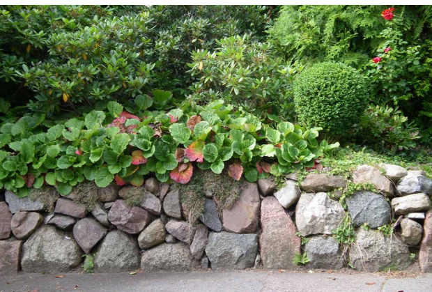
6.7.11 oben links Trockenmauerwall in Dänemark
