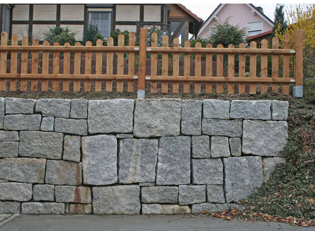
2.3.20 Hammerrechtes Schichtenmauerwerk: Schicht auf Schicht mit einigen Unterbrechungen, in denen senkrecht gestellte Granitquader die Mauer auflockern.
