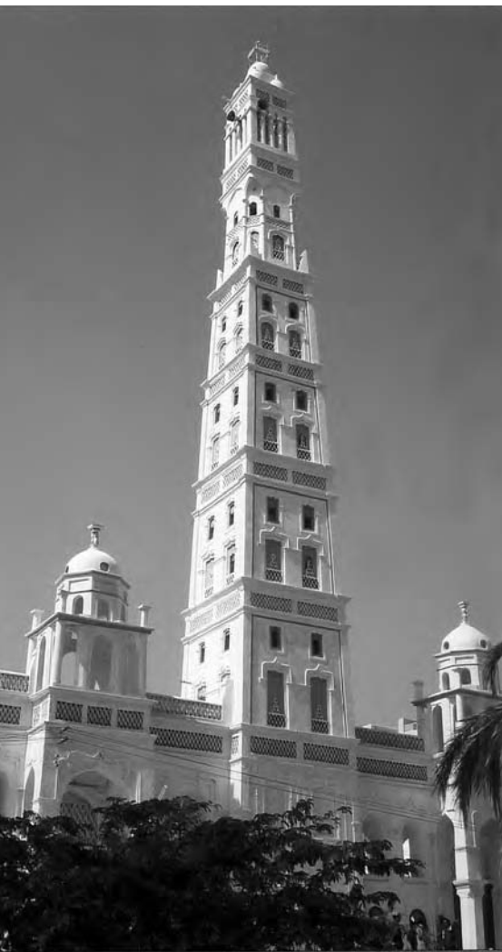
38 m hohes Minarett aus handgefertigten Lehmsteinen erbaut, Tarim, Südjemen
